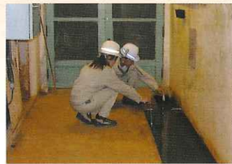
監査廊の内を流れている水の量を測り、ダムから水がもれていないかチェックしています。
