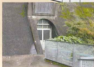
ここがダム内部への出入口。
