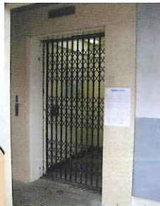
ダム内部の見回りや点検、維持補修作業を効率良く行うためエレベーターもあります。
