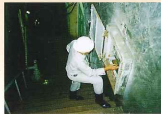
ダムが水におされて傾いていないか点検しています。
