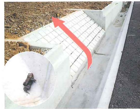
●スロープがあることで小動物は側溝から脱出できます。
