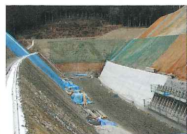
6 付替国道418号・2号トンネル坑口/八百津町小久後
