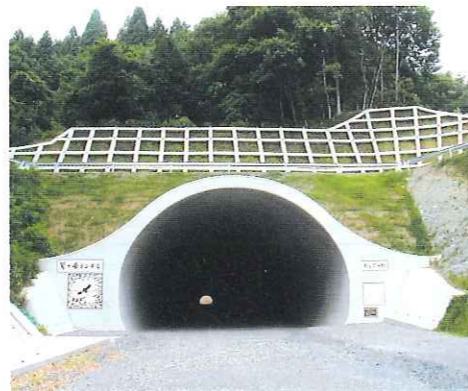
一般国道418号/鷲ヶ峰トンネル
