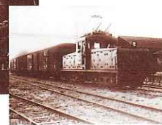
運搬に利用した電気機関車
