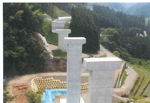
原石山線/1号橋
