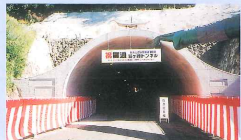
貫通した鷲ヶ峰トンネル
