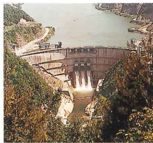
矢作ダム(アーチダム)
