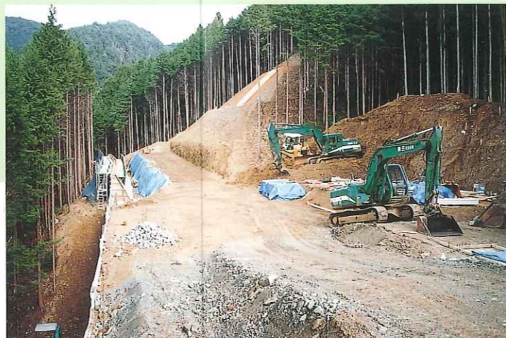
2 ダムの骨材となる原石を採取・運搬するための道路をつくっています。
