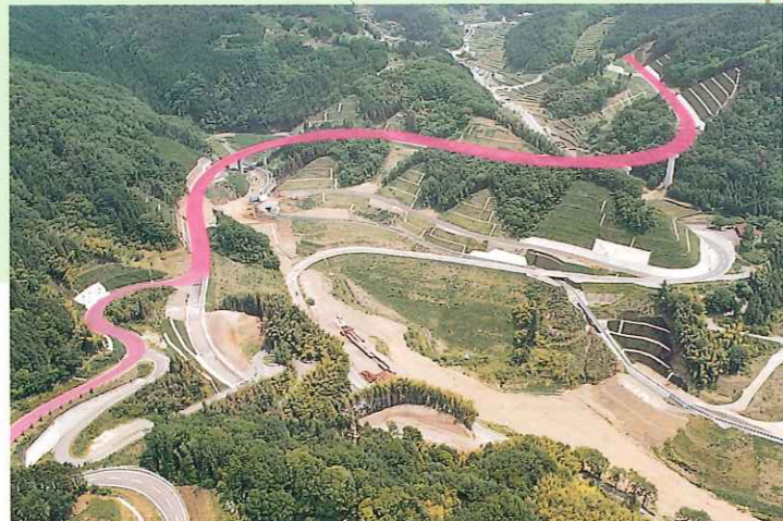
1 付替国道418号の工事を継続して実施します。
