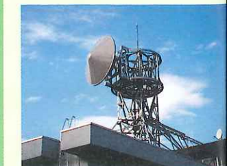
▲新しく取り付けられたアンテナ
