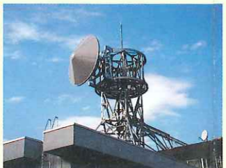
▲新しく取り付けられたアンテナ
