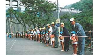
●オープニング40年テープカット 園児、御来賓、関係者によるテープカット。完成40周年の丸山ダムの前で。
