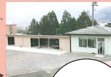
3月に完成した車庫▶
