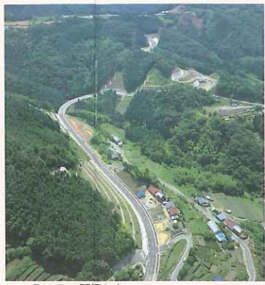
▲4月21日に開通した一般国道418号八百津バイパス・原石山線
