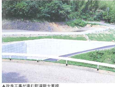
▲改良工事が進む町道新大峯線
