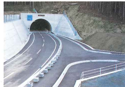
●丸山トンネル(諸田側)
