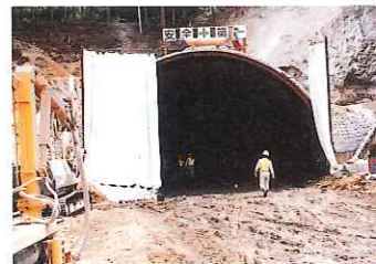
丸山トンネル 工食用道路として使用される丸山トンネル(全長181m)の工事が、今秋の貫通を目指して進められています。(供用開始平成5年度末を予定)車道の幅7m歩道も2m幅で付設されます。
