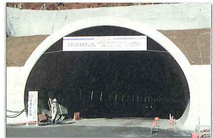
貫通した下立トンネル
