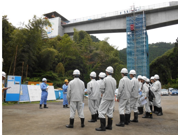
新小和沢橋建設現場
