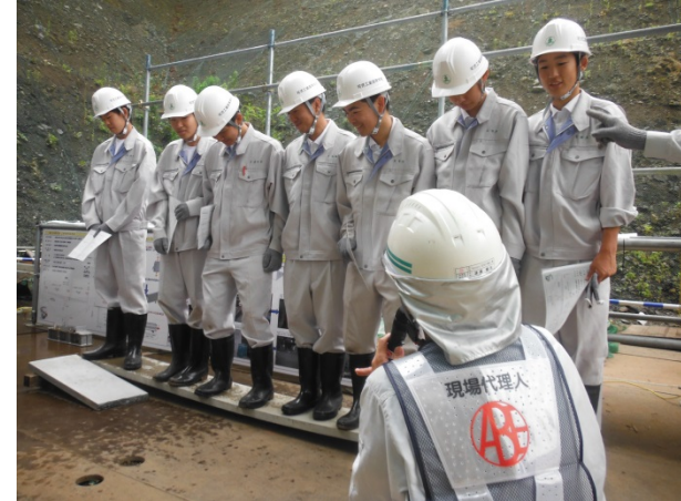
コンクリート板に乗る生徒
