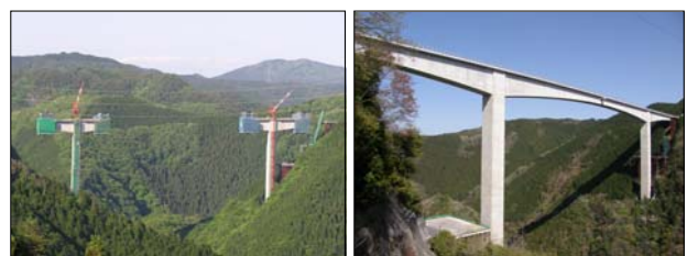
写真-1 施工中・完成後の新旅足橋
