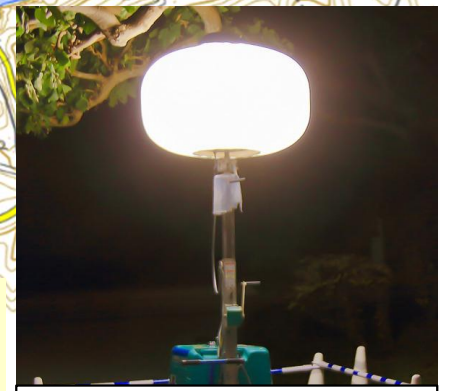
工事での夜間照明 (バルーン型投光器)
