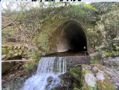
河川沿いの水路 (ダム下流 錦織地区)
