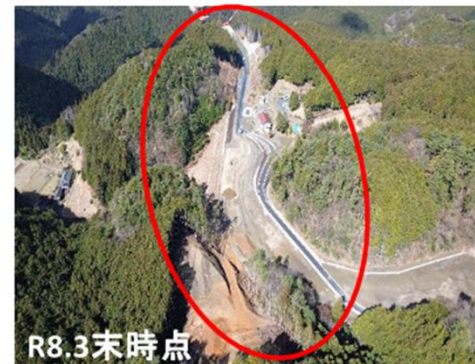
③令和8年度 新丸山ダム国道418号西山地区道路整備工事 土工を施工する準備をすすめています。
