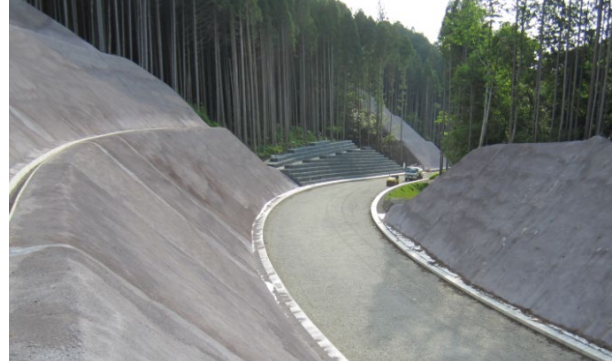
コンクリート吹付け (付替県道井尻八百津線)
