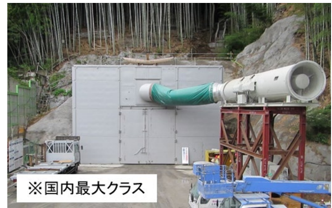
コンクリート充填型2層防音扉
