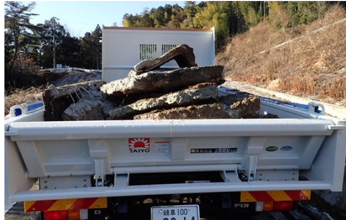
取壊したアスファルトコンクリート塊を 再資源化施設へ搬入
