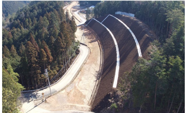
厚層基材吹付け (付替国津418号)
