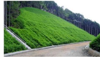
在来種による法面緑化（施工1年後）
