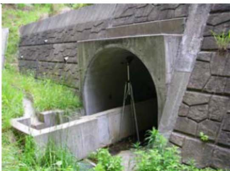
出入口の状況
