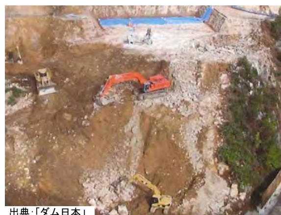
本体基礎掘削のイメージ
