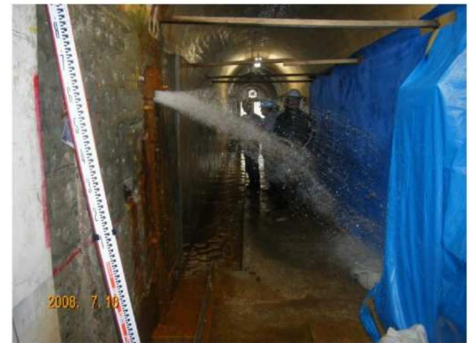
写真－ 2.2.3 4BL 漏水箇所の飛散防止カバーを外した状況(平成 20 年 7 月)
