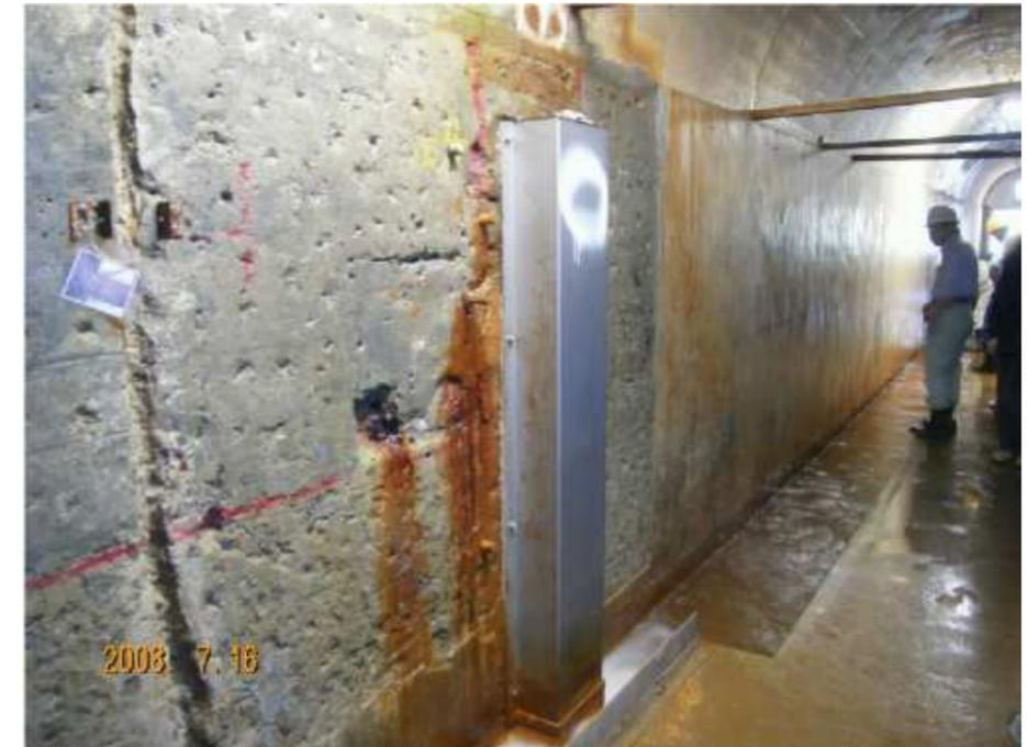
写真－ 2.2.2 飛散防止カバー設置後の状況
