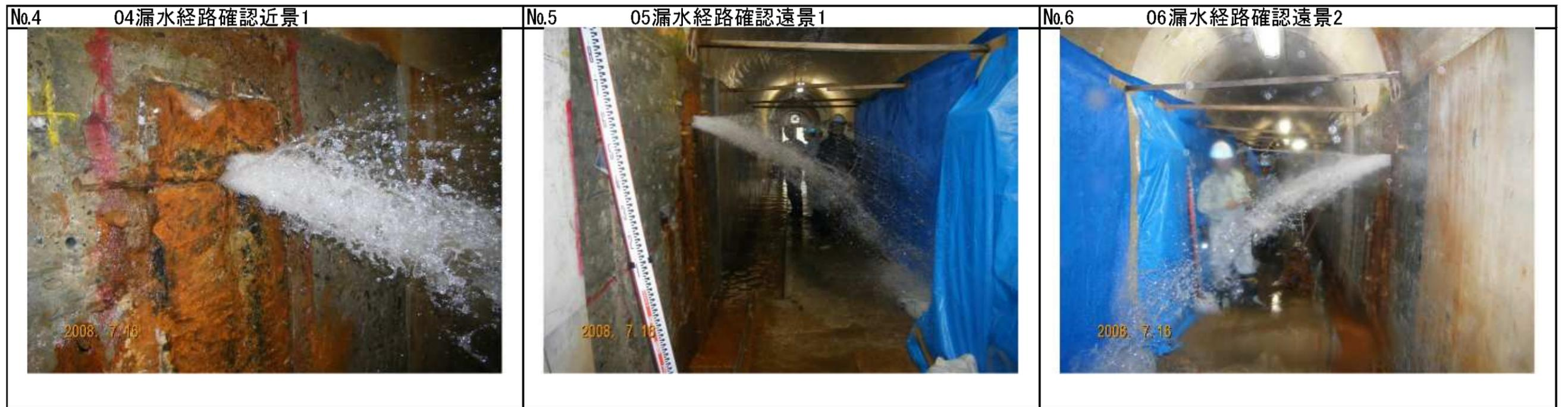
写真 - 2.4.13 漏水状況写真
