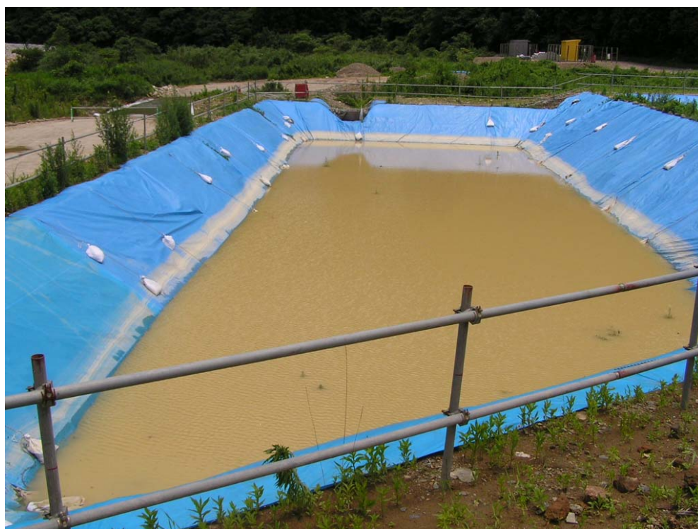
写真 5.4-1 沈砂池の設置例
