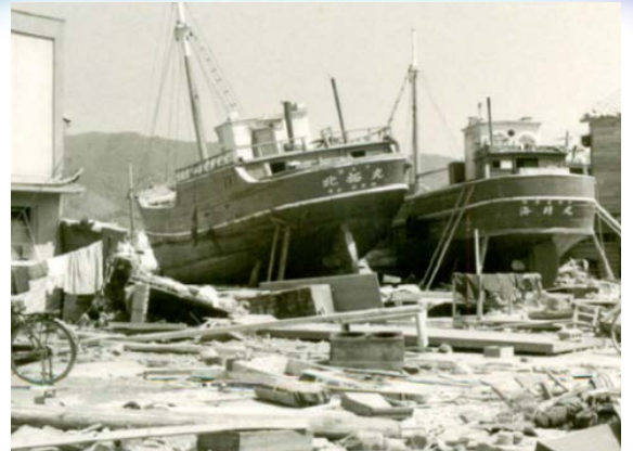
1944年昭和東南海地震 尾鷲港の被災状況
