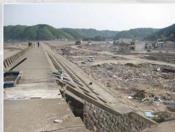
◇津波で損壊、越流した田老防潮堤 (岩手県宮古市)
