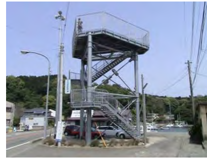
津波避難タワー(静岡県沼津市)
