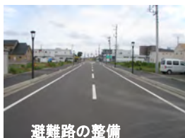
避難路の整備
