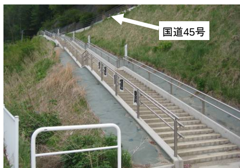
◇津波避難階段（岩手県岩泉市）
