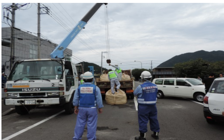
道路啓開（河津町役場前）
