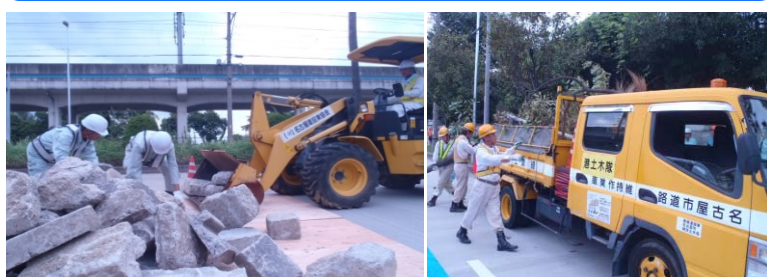
道路啓開(名古屋市)
