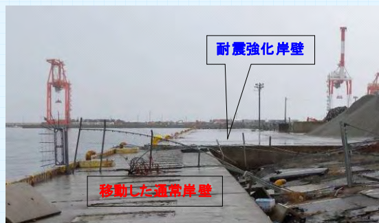
◇耐震強化岸壁（仙台塩釜港 仙台港区）
