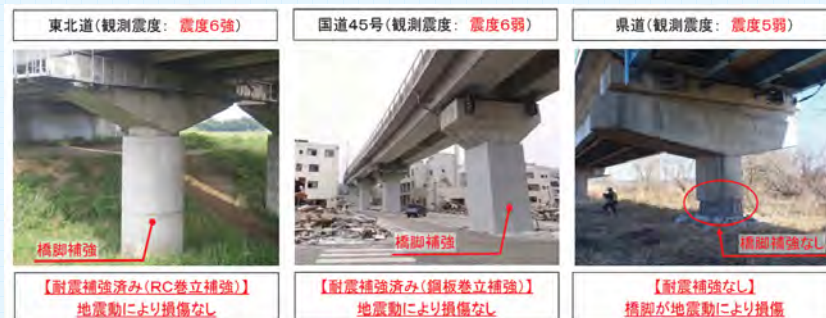
◇橋脚耐震補強（東北道、国道45号）
