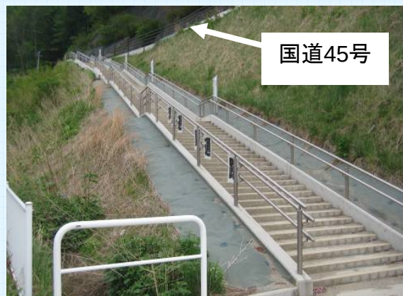
◇津波避難階段 （岩手県岩泉市）
