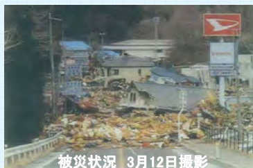
被災状況 3月12日撮影
