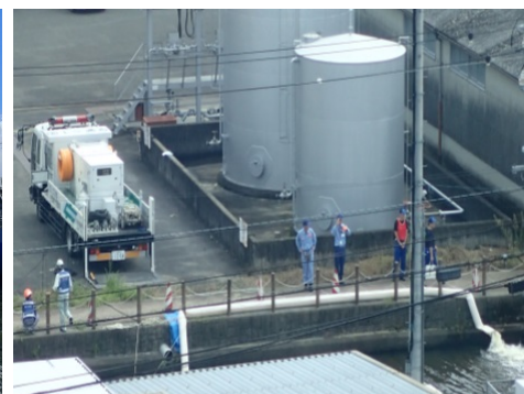
排水ポンプ車による排水作業(木曾岬町)
