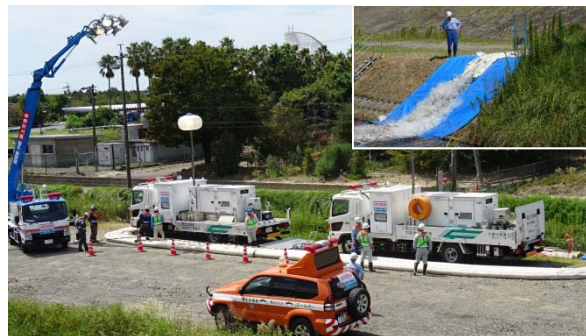
排水作業の実施
