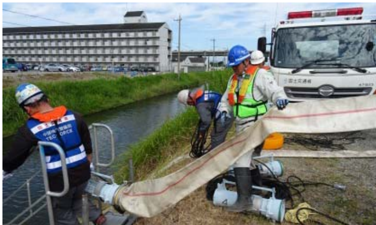
排水ポンプの設置作業
