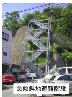
急傾斜地避難階段
