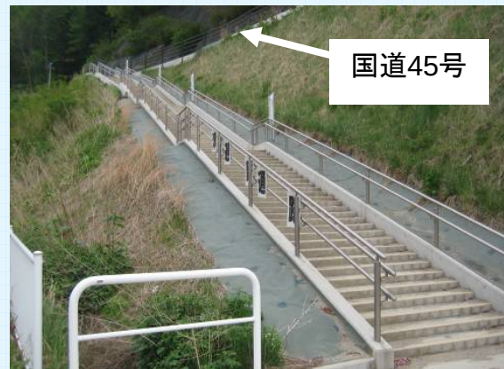
◇津波避難階段 （岩手県岩泉市）
