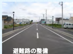
避難路の整備
