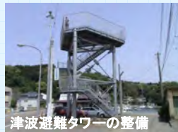
津波避難タワーの整備
