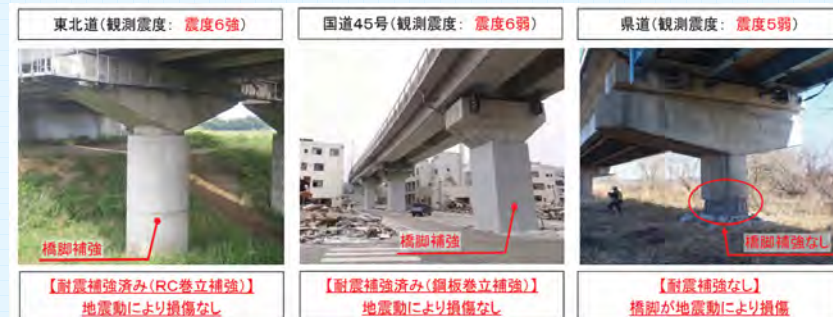
◇橋脚耐震補強（東北道、国道45号）
