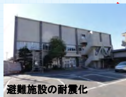
避難施設の整備
