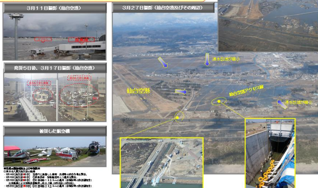
◇仙台空港周辺の緊急排水作業
