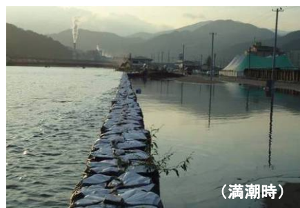
◇地盤沈下のため大潮時に浸水する岸壁（釜石港 須賀地区）
