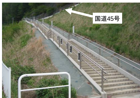
◇津波避難階段（岩手県岩泉市）
