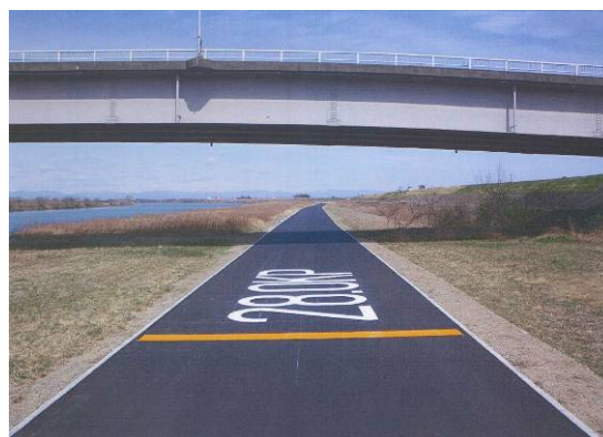
◇対空表示の設置（緊急用河川敷道路）
