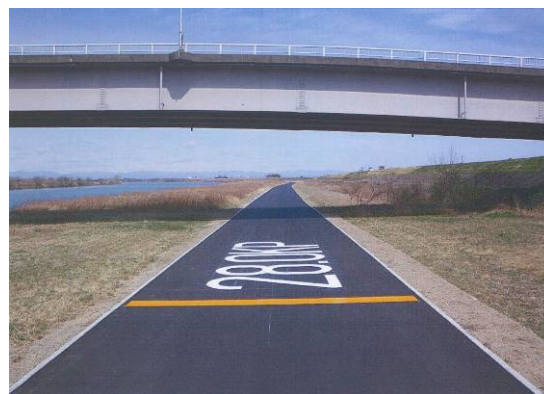
◇対空表示の設置（緊急用河川敷道路）
