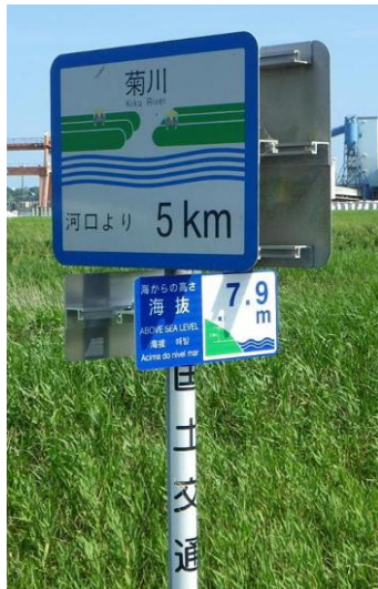
◇河川堤防距離標への海拔表示
