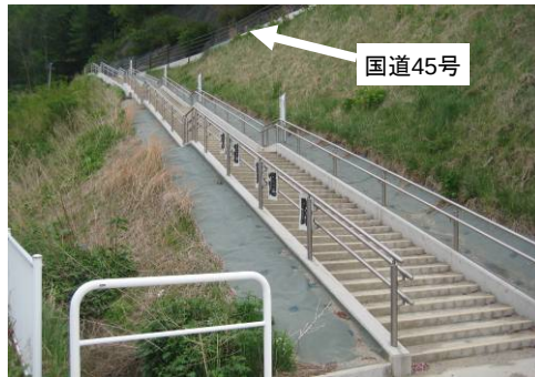
◇津波避難階段（岩手県岩泉市）
