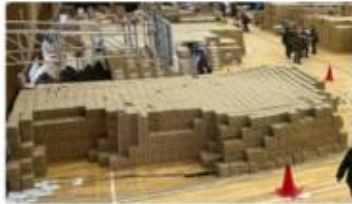
床が抜け落ちた体育館
