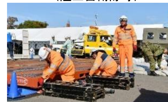
路面段差解消訓練 (中部地整TEC-FORCE等)
