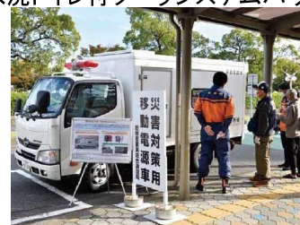
総務省東海総合通信局 災害対策用移動電源車
