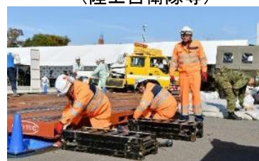
路面段差解消訓練 (中部地整TEC-FORCE等)
