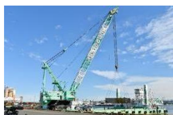
航路啓開訓練 (中部地整TEC-FORCE)
