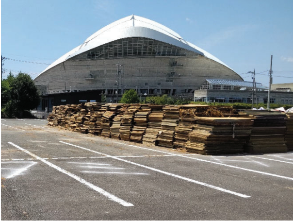
環境省撮影 石川県小松市 仮置場策状況 (令和4年8月8日時点)
