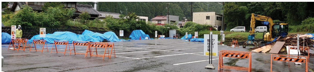
環境省撮影 岐阜県白川町 仮置場雨対策状況(令和3年8月17日時点)
