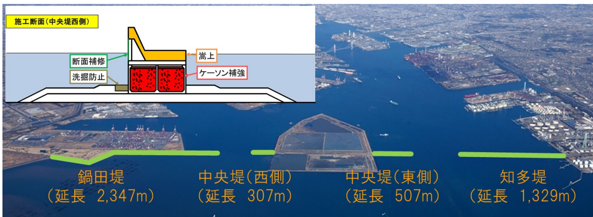
◇防波堤の整備事例 (名古屋港外港地区防波堤)
