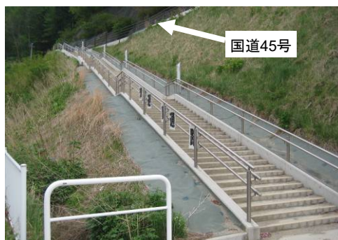
◇津波避難階段（岩手県岩泉市）
