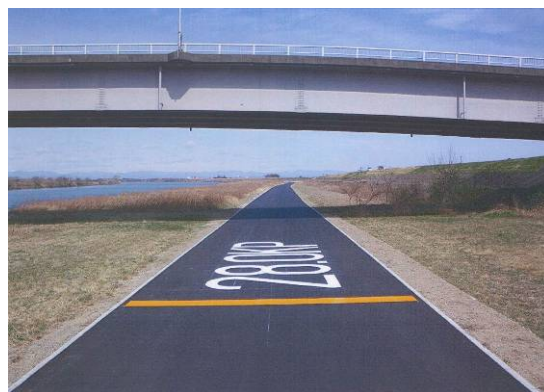
◇対空表示の設置（緊急用河川敷道路）
