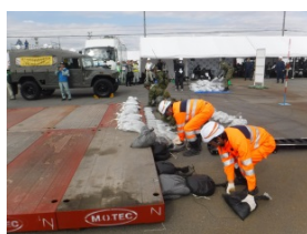
道路啓開訓練 （中部地整TEC-FORCE等）
