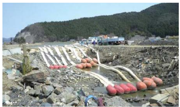
東日本大震災における排水状況
