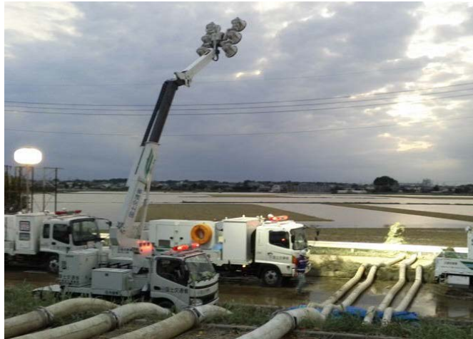
排水ポンプ車による排水作業
