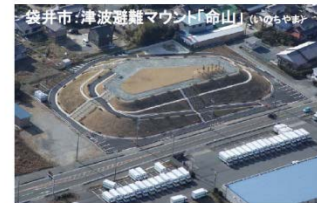
磐田市:津波避難ビル(長池配水場)
