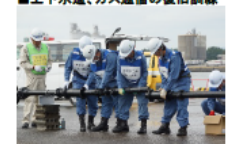
<宮崎県工事共同組合等による復旧訓練>
