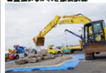
<県建設業協会等によるがれき撤去>
