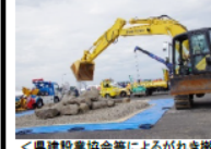
<県建設業協会等によるがれき撤去>
