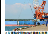
<災害協定団体の起重機船啓開>
