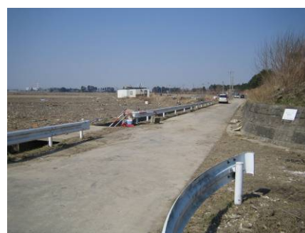
◇仙台東部道路より陸側(西側)
