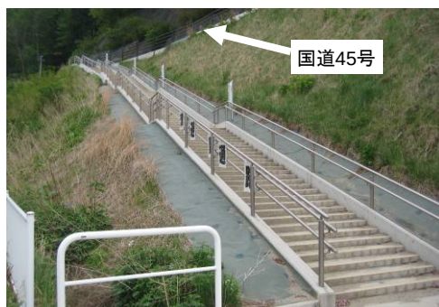
◇津波避難階段（岩手県岩泉市）
