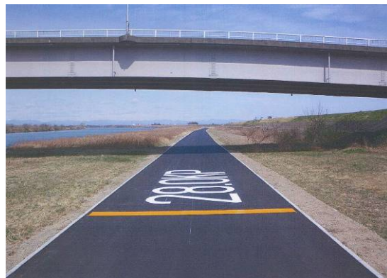
◇対空表示の設置（緊急用河川敷道路）
