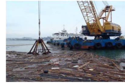
作業船による揚収物除去作業の様子
