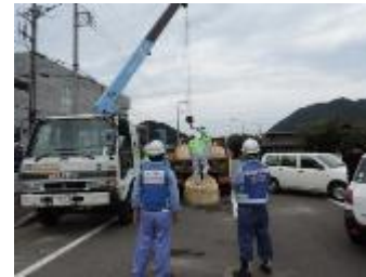
【沼津河川国道、静岡県、陸上自衛隊、建設業協会等による道路啓開】
