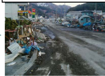
道路啓開作業後
