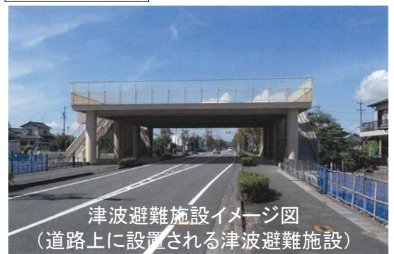
避難施設の整備
