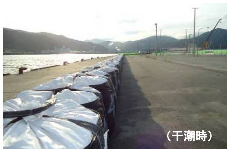
◇地盤沈下のため大潮時に浸水する岸壁（釜石港 須賀地区）
