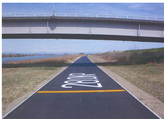
◇対空表示の設置（緊急用河川敷道路）
