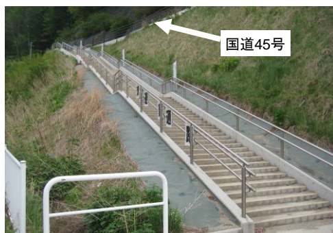
◇津波避難階段（岩手県岩泉市）
